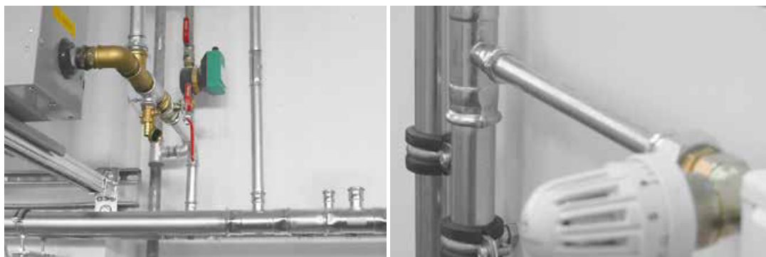
Примеры монтажа оборудования KAN-therm Steel
